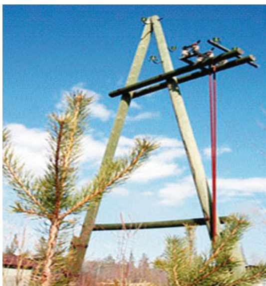
Рис. 1. Деревянная А-образная опора (Канада).
