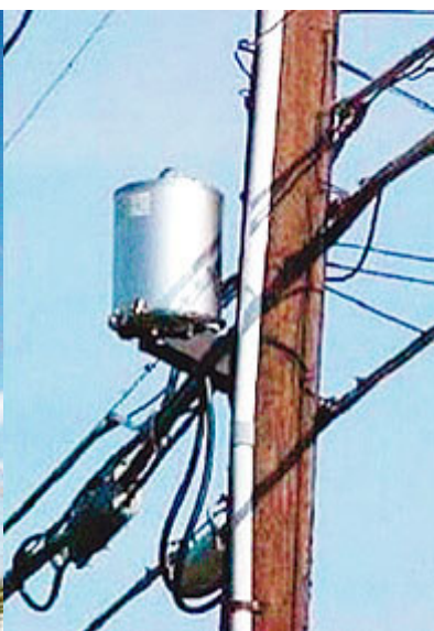
Рис. 2. Деревянная опора со столбовой ТП (США).
